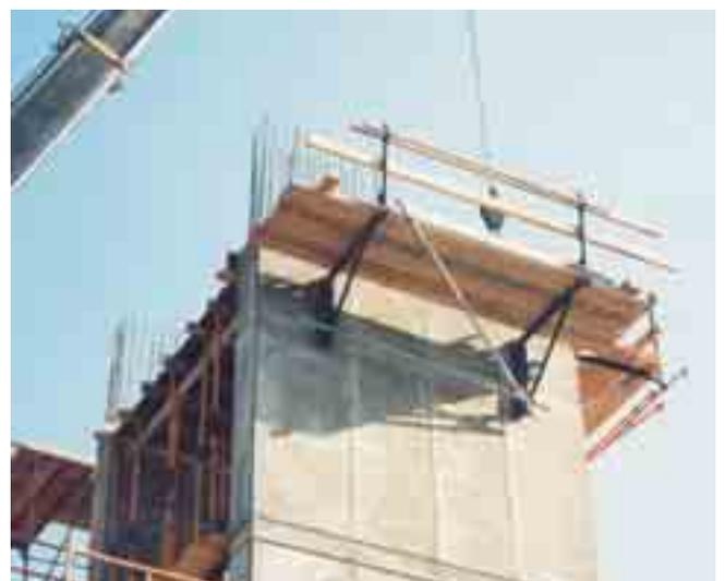
El apoyo de la consola de trepado se realiza sobre el **Encaje NT15** que se atornilla a un **Cono DW15/M24** embebido en el muro de la tongada inferior.
