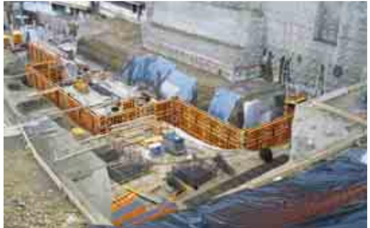
▲ El Encofrado Modular ORMA es capaz de solucionar las diferentes geometrías que se presentan en la ejecución de estructuras verticales
