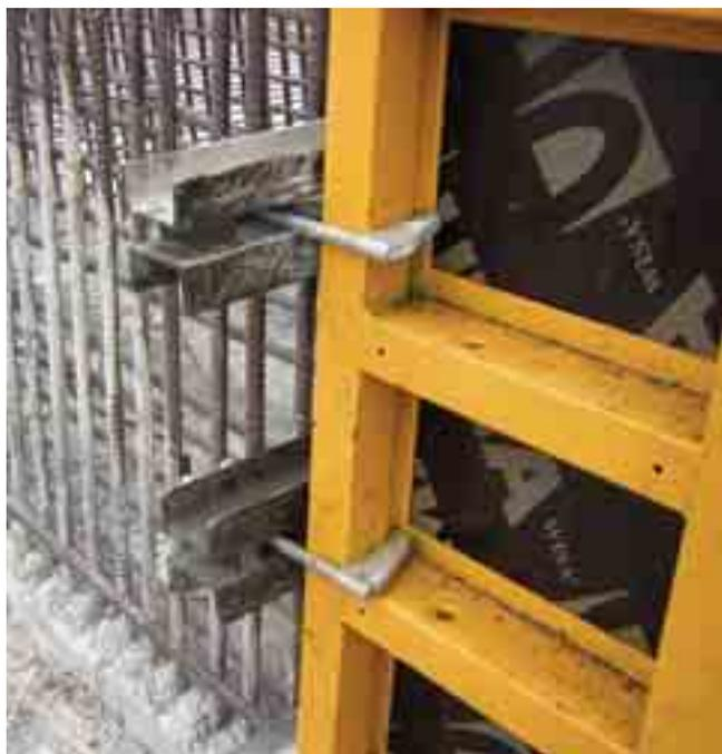
▲ Fijación del Rigidizador mediante ganchos de Cierre amarrados al perfil
