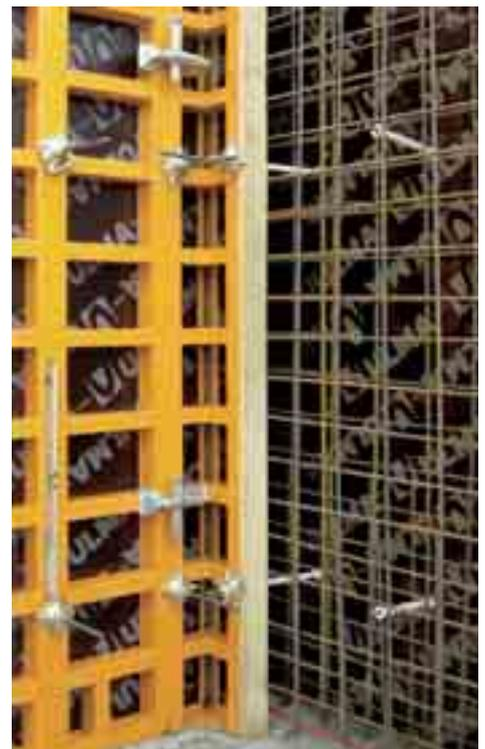
▲ El diseño de la tuerca permite el paso de las Barras Roscadas
