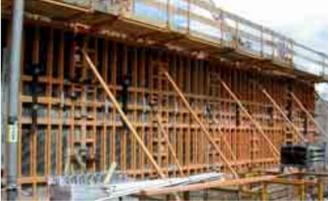
La instalación de la plataforma sólo requiere el despliegue de la barandilla y su izado con grúa a través de unas argollas dispuestas para este fin. Este sencillo montaje finaliza colocando la plataforma mediante ganchos, sobre el perfil del último panel.
