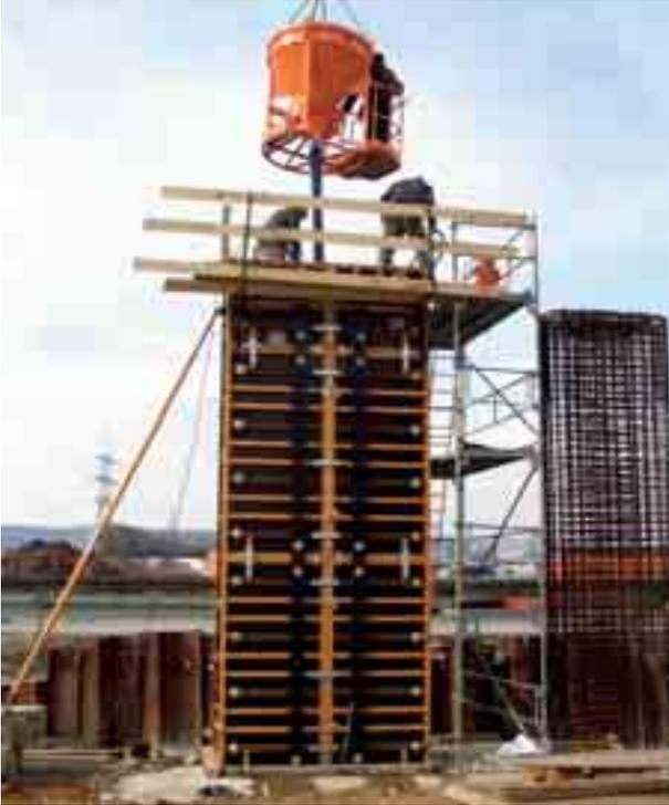
Puede utilizarse también como panel de muro; de ahí que esté dotado de agujeros en el perfil perimetral para el paso de las Barras Roscadas.
